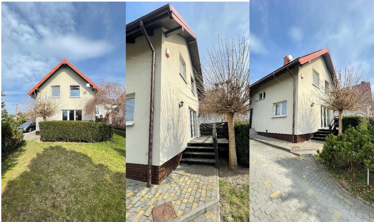
Rysunek 3 Analiza fasady budynku
