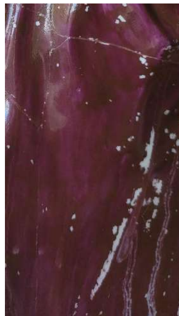
Ilustracja 55: Zbliżenie na zacieki na szkliwie znajdujące się na dolnej części płaszcza figury Augusta III Sasa. Fot. Jagoda Adamek. Kraków, 2024.
