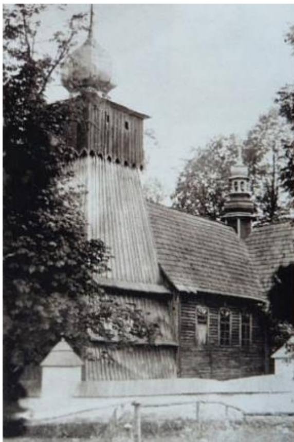
Il. 3 Drewniany kościół pw. św. Jana Chrzciciela w Olszówce, widok od strony południowej.
