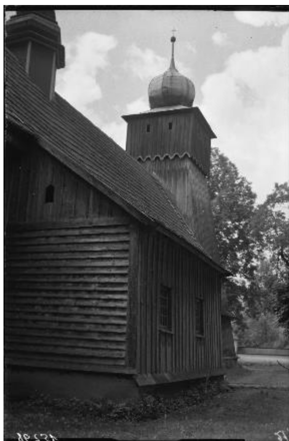
Il. 24 Zakrystia kościoła w Olszówce, widok na północny wschód. Po lewej stronie fotografii widoczne okno z witrażem.
