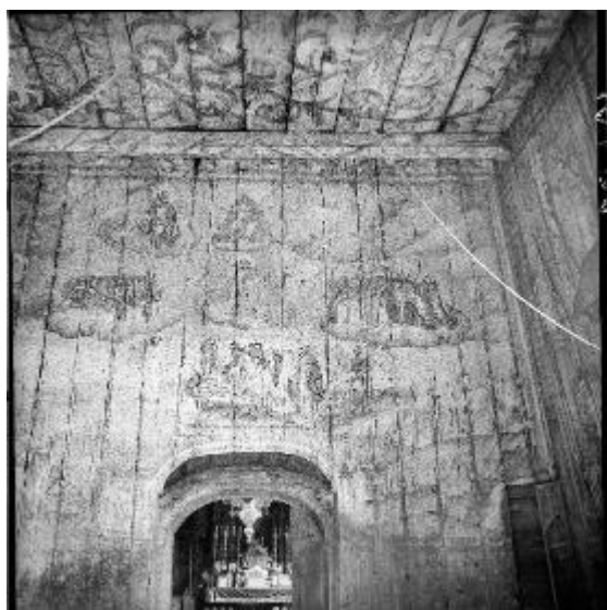
Il. 17 Wschodnia ściana i belkowy strop w wieży.
