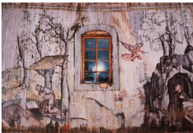
Il. 131 Fragment fotografii figuralno-ornamentalnej polichromii na ścianie południowej w pomieszczeniu pod wieżą, z cyfrową rekonstrukcją malowidła
