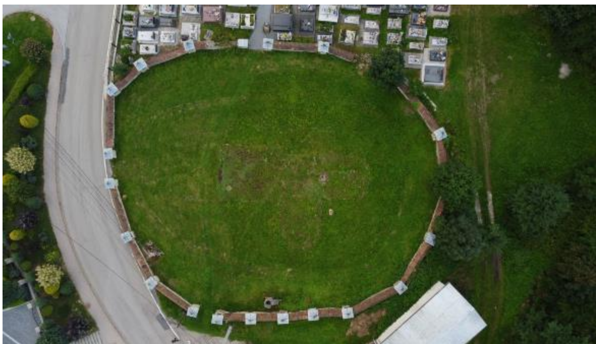
Il. 98 Teren drewnianego kościoła pw. św. Jana Chrzciciela w Olszówce przed odsłonięciem kamiennej posadzki i podmurowania nawy i prezbiterium. Fotografia lotnicza wykonana przy użyciu dronu
