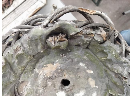
Il. 40. Fragment gniazda podczas demontażu. Widoczne wnętrze elementu oraz tapy piskłeta wskazujące na niegdysiejsze usadowienie ptaków. Fot. O. Gabryś, 2022 r.
