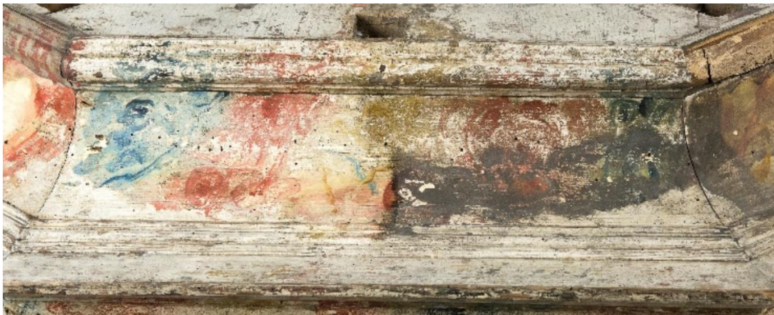
II. 52. Proces usuwania powierzchniowych zabrudzeń na jednym boków podstawy pokrywy. Fot. P. Gąsior, 2023 r.
