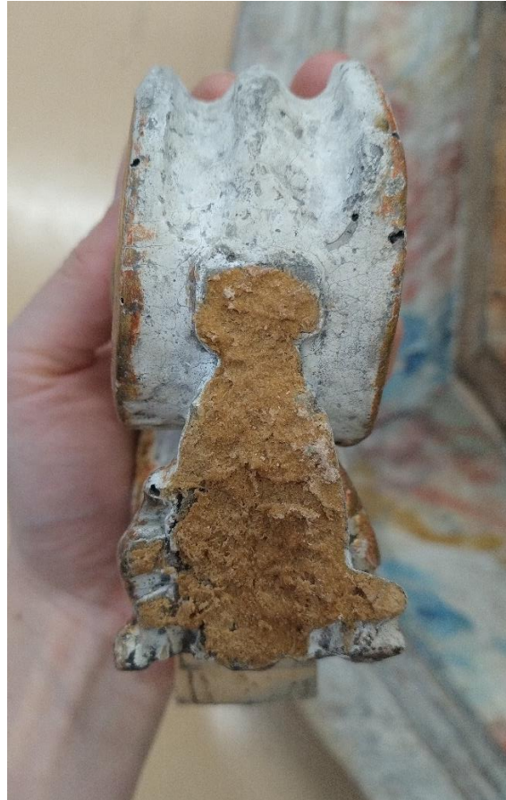
Il. 69. Warstwa z żywicy Paraloid B-72 z pyłem drzewnym nałożona w miejscu przełamania konsoli.
