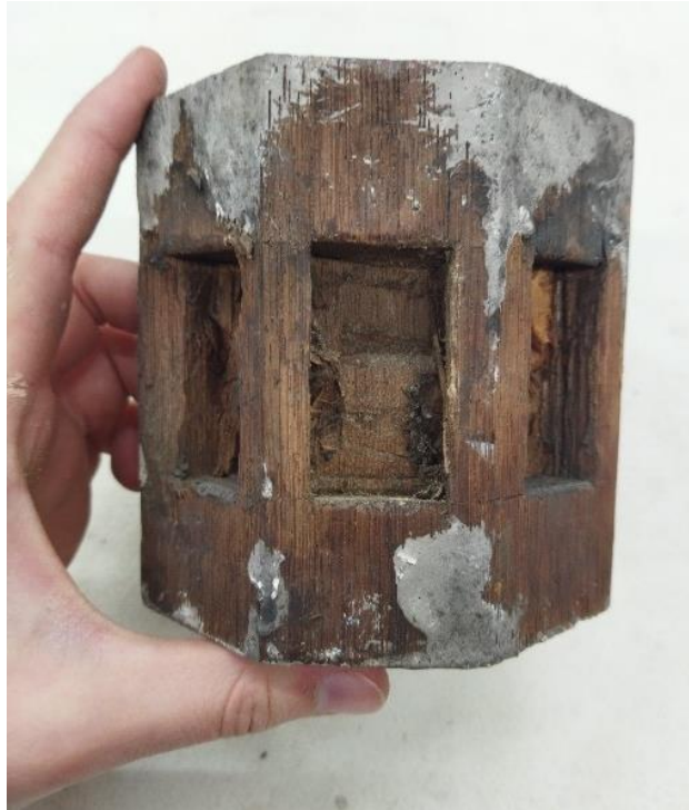
Il. 38. Element konstrukcyjny, spinający konsole w górnej części. Fot. O. Gabryś, 2023 r.
