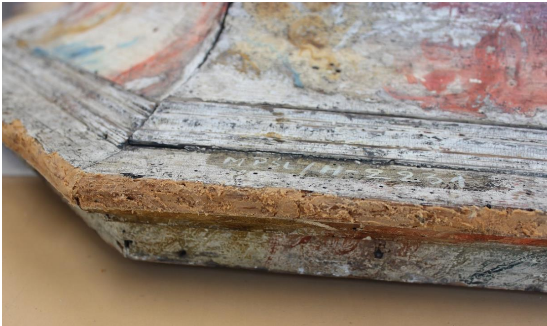
Il. 57. Proces uzupełniania ubytków drewna przy krawędziach podstawy. Fot. O. Gabryś, 2024 r.
